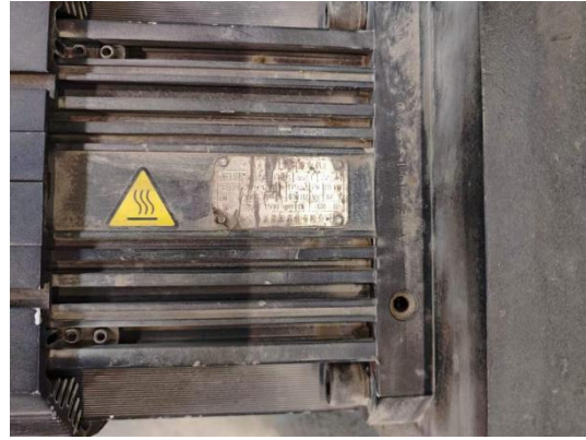
液压站主电机更新 2
